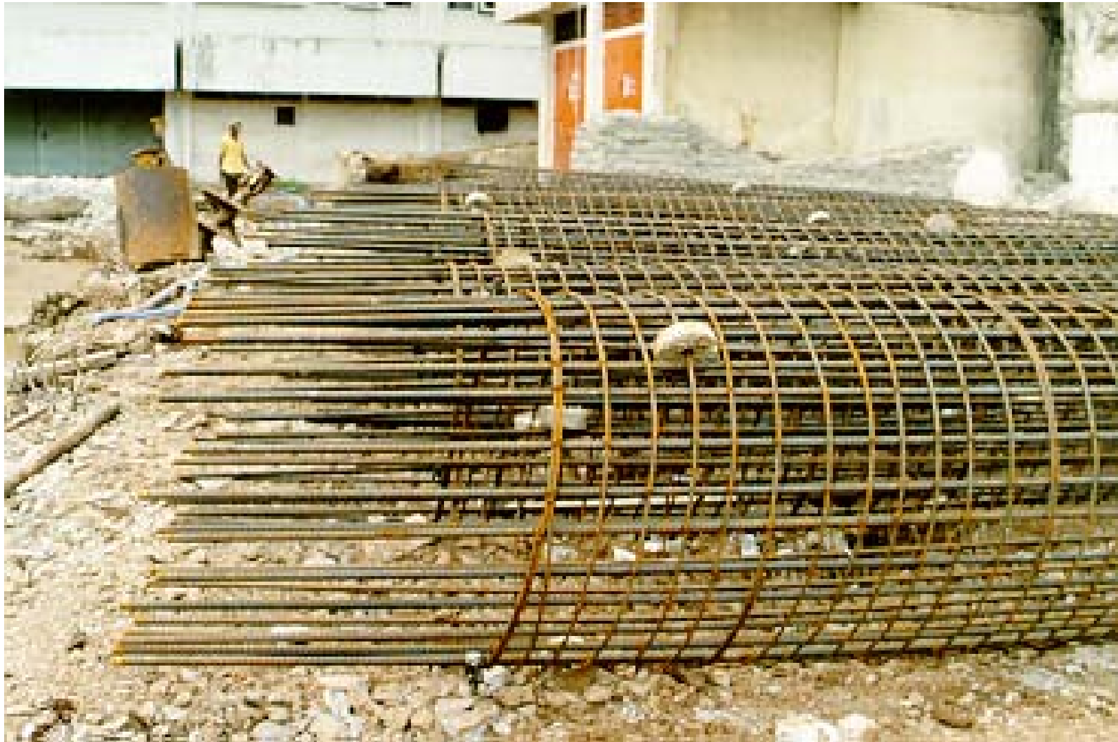
PEMBESIAN BORED PILE
