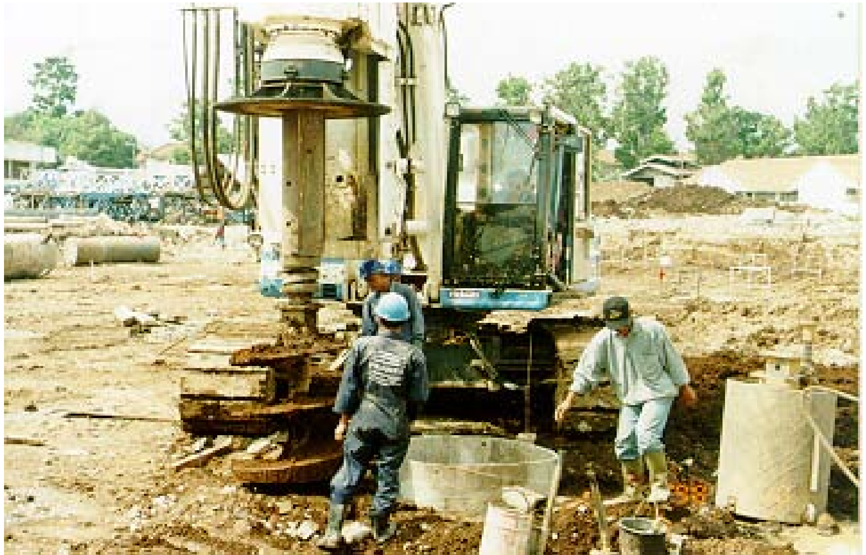
PENGUKURAN KEDALAMAN BORED PILE
